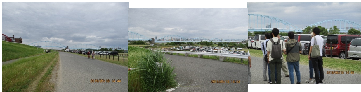
淀川水管橋上流側左岸堤防上
