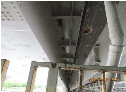
毛馬橋下流側拡幅増設桁（一主鋼床版箱桁）左岸堤防上
