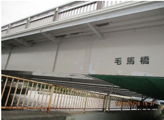
毛馬橋下流側拡幅増設桁（一主鋼床版箱桁）左岸堤防上
