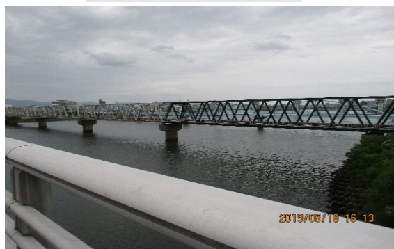
阪急千里線橋梁（全長の1/2のみ塗替え施工完了）
