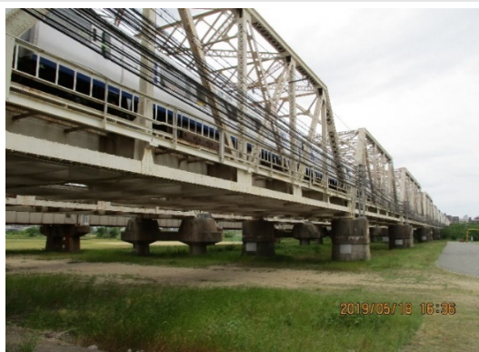
J R 淀川橋梁 (最下流側プラットラス) 橋 歴118歳・健全そのものの感あり
