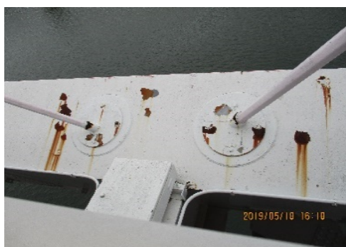
長柄橋補剛桁上フランジ上面塗装損傷 顕著部 (ケーブル定着部)
