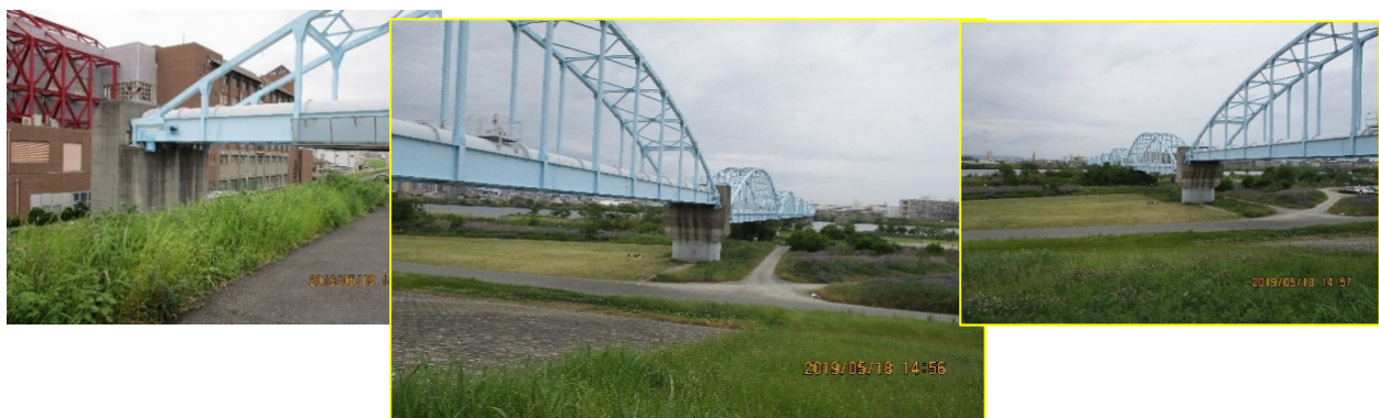
淀川水管橋上流側左岸堤防上
