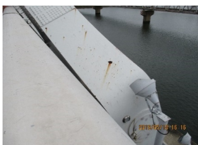
長柄橋補剛桁端隅角部
